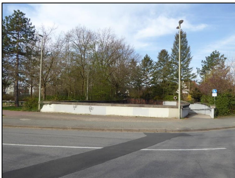
Abb. 2: Sicht auf das Plangebiet von der Kreuzung Pommernring-Fichtestraße-Mühlweg aus.
